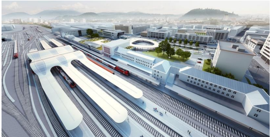
Graz Hauptbahnhof 2014, im Bau • Graz Bus Station 2014, under construction
